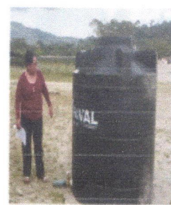
Tanque de agua tipo botella de 1100 lt. con grifo
